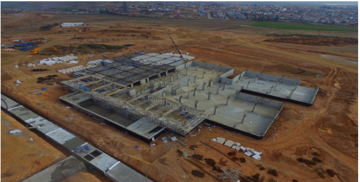
Merkezi Kafeterya Binası İnşaatı
