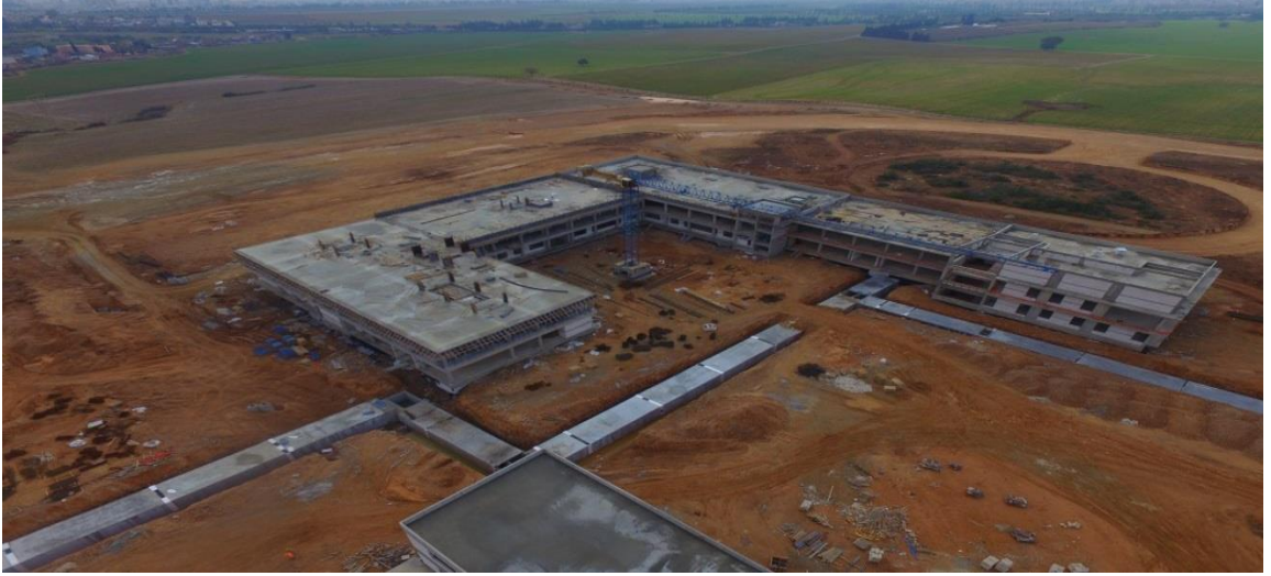
Rektörlük Binası İnşaatı
